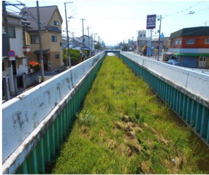
谷田川 現況写真
