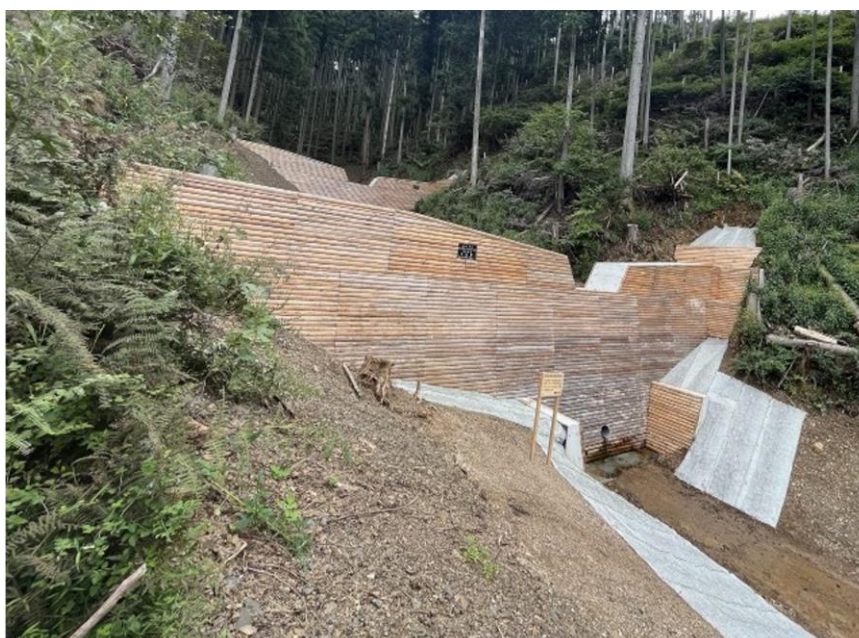
治山ダムの設置状況（R3）高槻市
