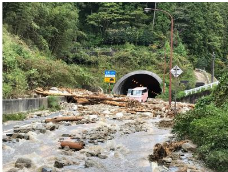
平成29年10月 千早赤阪村 豪雨による土石流により国道へ土石・流木等が流出
