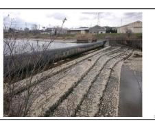
井堰には、コンクリートによる固定堰と、ゴム製の可動堰がありますが、 私の地元、石川においては、大雨で水嵩が増したときに川の流水を確保す るという治水上の理由により、可動堰であるゴム井堰を選択されたもの と承知しています。
