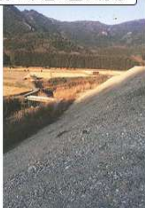
泉佐野土砂埋め立て現場
