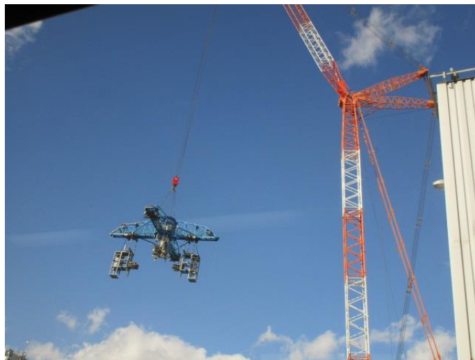
（解体作業のクレーン）
