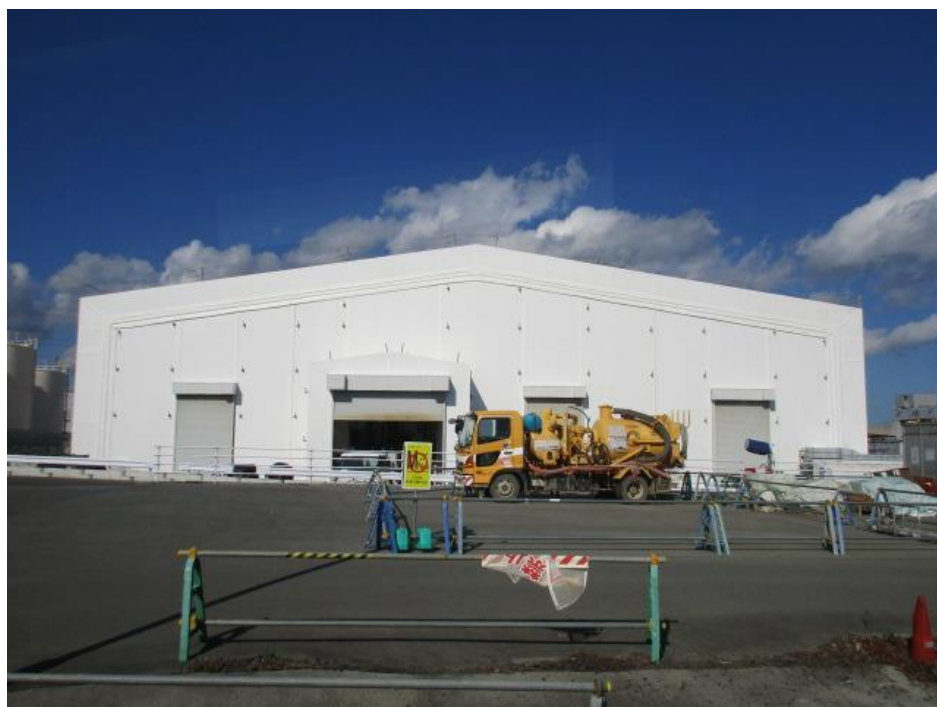
（多核種除去装置（アルプス）の建屋）
