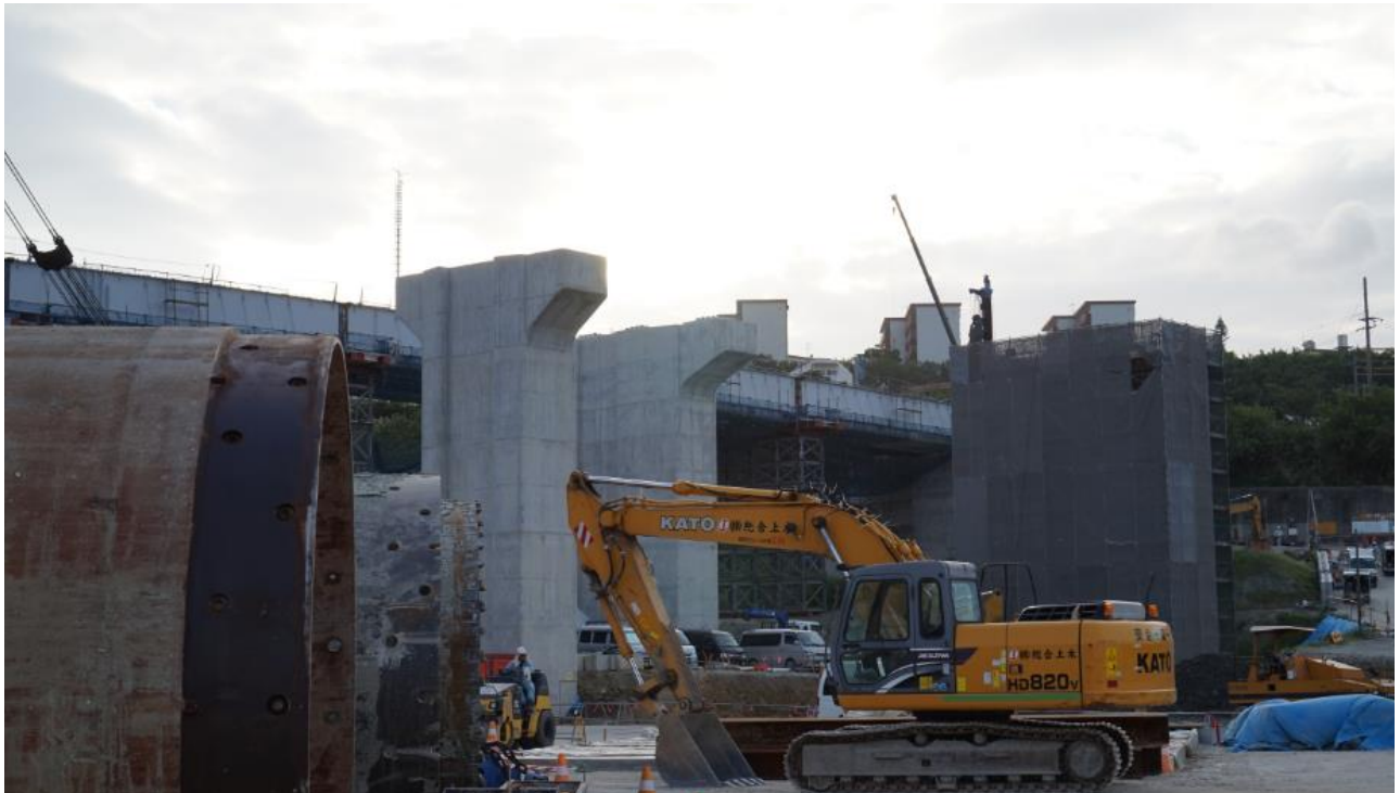
（沖縄県都市モノレール建設現場）
